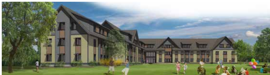
NORTH COMMONS | NORTHAMPTON
